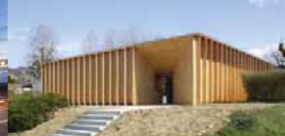
Sanitaires du Lac du Lit du Roi à Massignieu de Rives (01)
