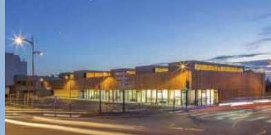
Gymnase Hacine Chérifi à Rillieux la Pape (69)
