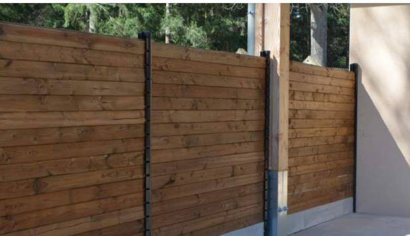
Les palissades sont composées de différents éléments à assembler. Les poteaux, demi-poteaux et raidisseurs constituent la structure dans laquelle ou sur laquelle se positionnent ou se fixent des lames de manière horizontale ou verticale par emboîtement, recouvrement ou à claire-voie. Une couvertine positionnée sur la dernière lame en partie haute assure une protection.
