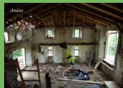
Chantier de rénovation Architecte : David Grimaud (07)
