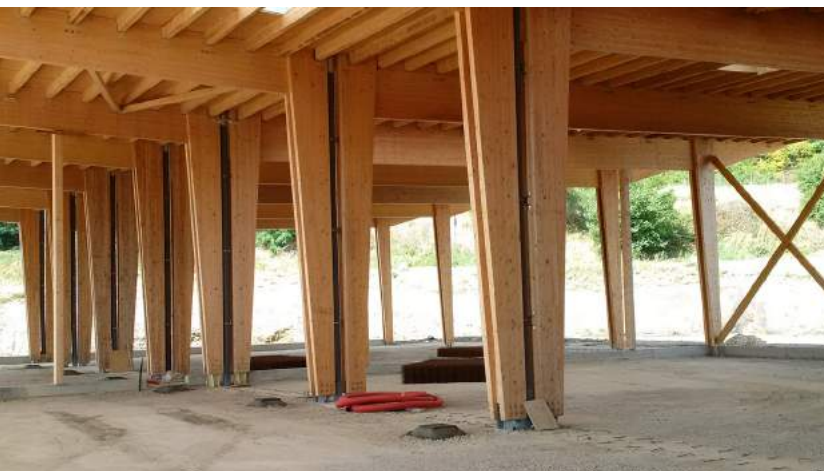
Bonner Architecture Ingenierie et Sophie Fayolle / Bâtiment d'activité / Saint-Chamond (42)
