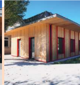
ÉCOLE DE NOUS- TOULET Saint-Germain- Laprade (43) Architecte : Marcillon Thuillier Architectes (63) ©Philippe Hervouet
