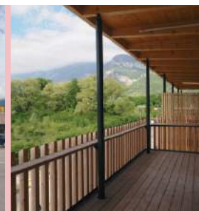
ECOCENTRE Crolles (38) Architecte : Atelier de la Place (38) ©Atelier de la Place
