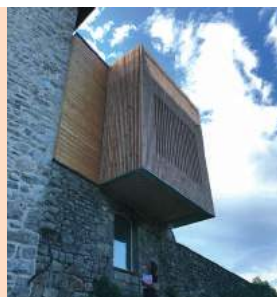
RÉNOVATION DU PRESBYTÈRE Sainte Marguerite Lafigère (07) Architecte : Tam Tam Archi- tecture (69) ©Tam Tam Architecture
