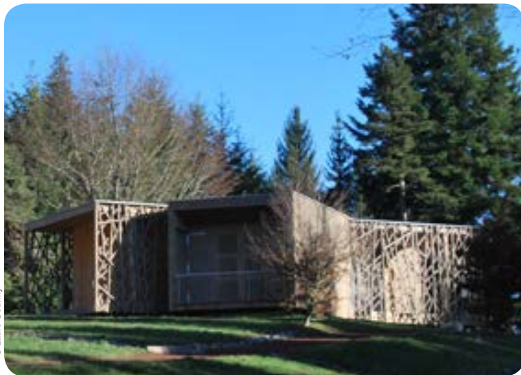
Structure, revêtement et menuiseries en douglas
