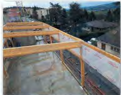
Cantine scolaire à Saint-Genest Lerpt – architecte : Hiatus Atelier.
