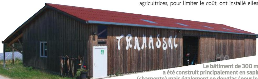
**Le bâtiment de 300 m<sup>2</sup> a été construit principalement en sapin (charpente) mais également en douglas (pour les poteaux). Les bardages ont reçu un traitement autoclave.**
