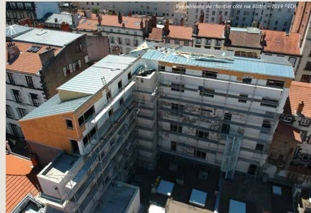
Vue aérienne du chantier côté rue Blatin - 2019 ©ECH
