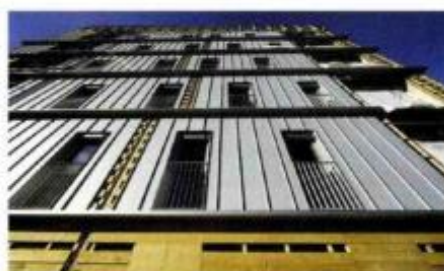
Les panneaux d'enveloppe avec isolation, menuiseries et bardage zinc, ont été mis en place.
