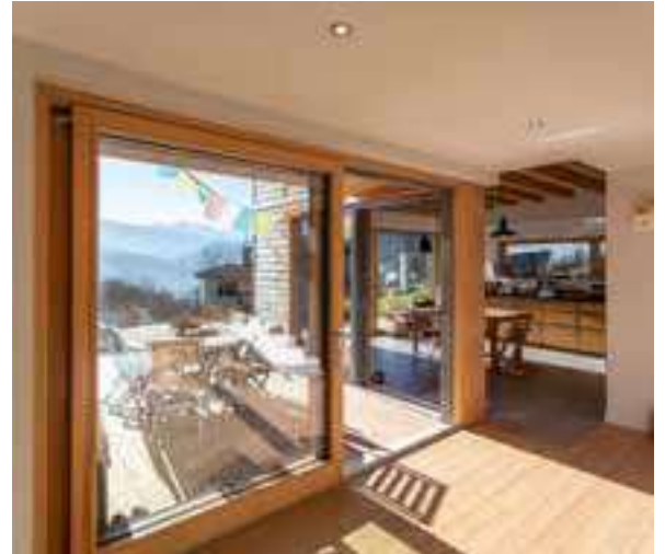
Menuiseries extérieures bois/alu en pin sylvestre - Face à Belledonne (38) - ©Jim Prunier - Gasnier-Eco Architectes
