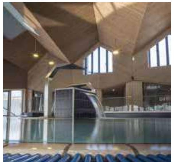
Revêtement intérieur en douglas - Piscine aqualudique du Stade de Chambéry (73) - ©Tommaso Morello - Grand Chambéry - ALN Ateliers Architecture
