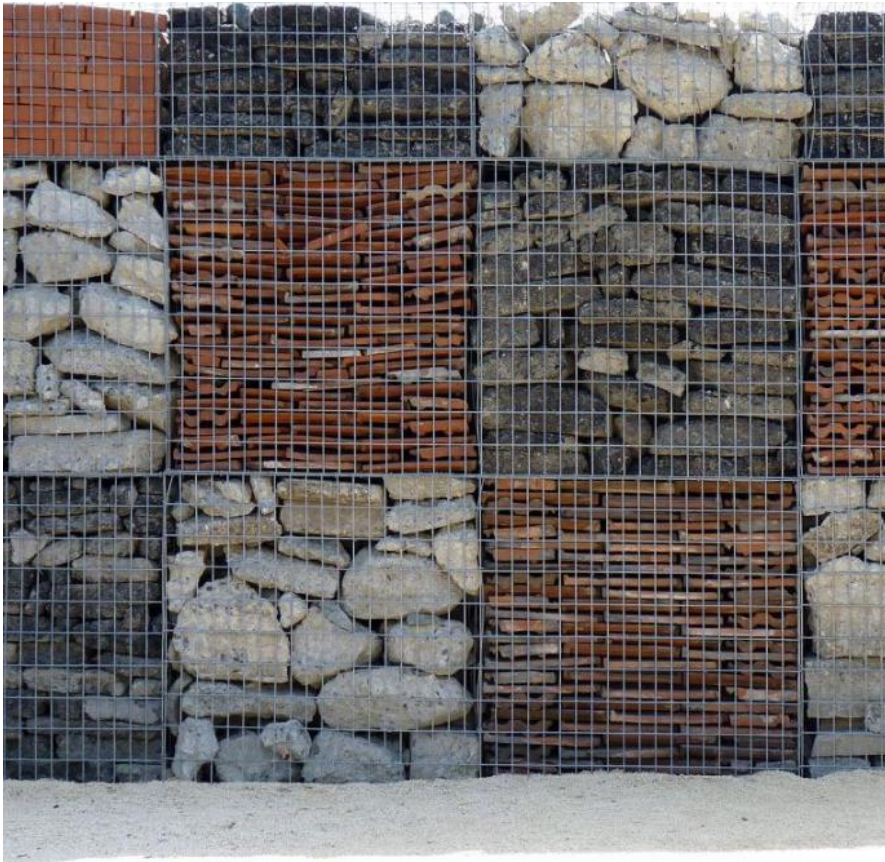
Déchèterie le Court-circuit à Saint-Martin d'Hères, NA Architecture Mur d'enceinte en gabions de réemploi.
