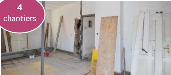
La collecte en chantier : rénovation et curage
