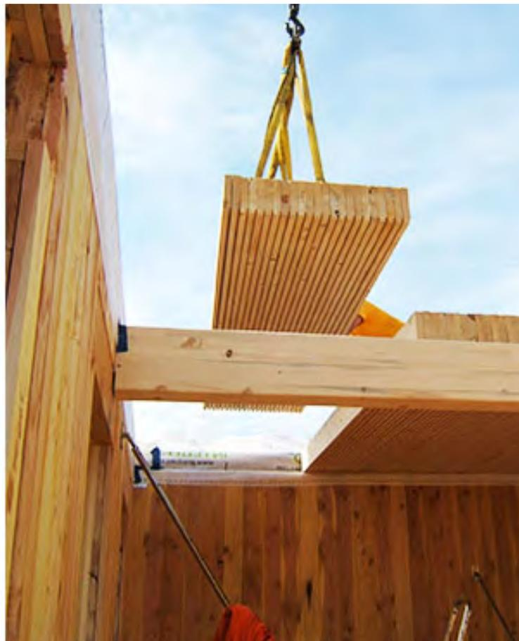
Le concept du plancher collaborant bois-béton est de substituer la partie en traction d'une dalle en béton armé traditionnelle par du bois massif solidarisé avec du béton travaillant en compression.
