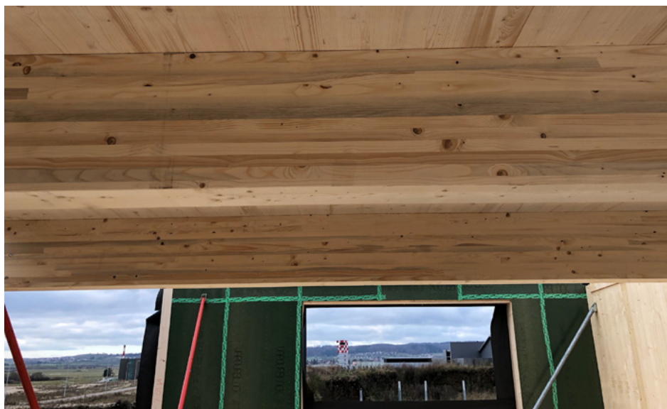
Construction des bureaux de Tekicéa en ossature bois d'épicéa scolyté / crédit ©Tekicéa
