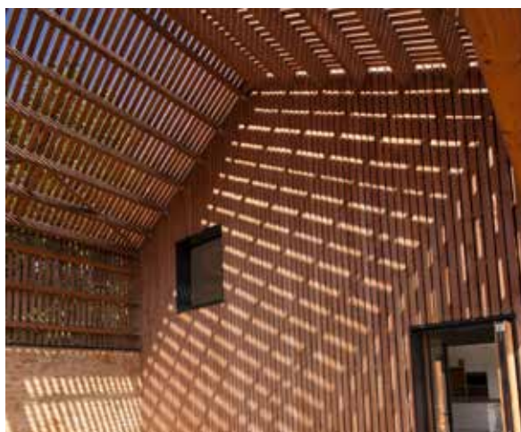
Structure en douglas - Maison individuelle - Montembœuf (16) - ©Thomas Kyle
