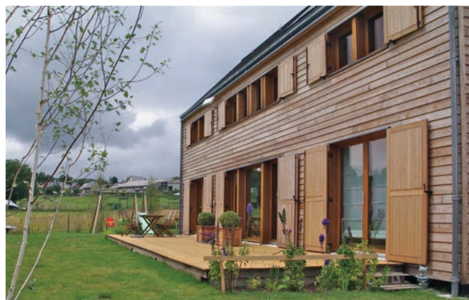
Volets battants à cadre remplissage lames de bois massif - Architecte ©Fernand Ribeiro
