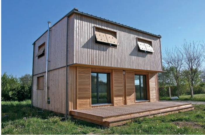
Volets coulissants au rez de chaussée et volets persiennes repliables à l'étage - Architecte ©Fernand Ribeiro
