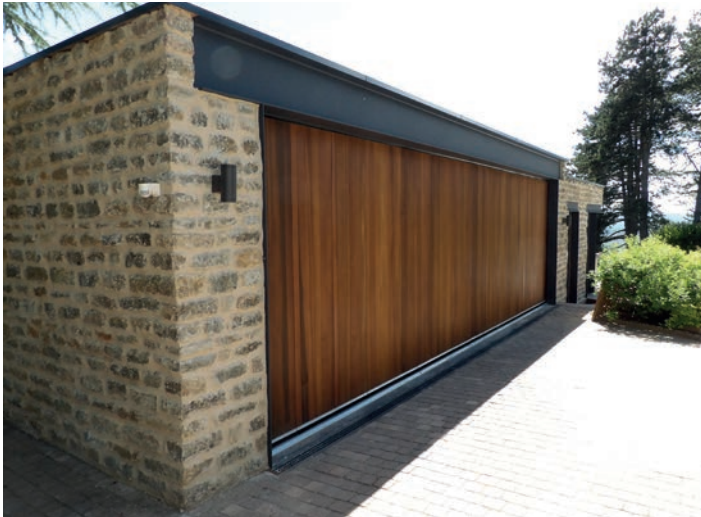
Porte de garage latérale motorisée ©GPF La Fermeture Bois (42)
