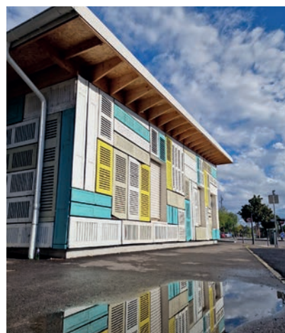
Architecte : Meiosis Architecture Architecte collaborateur : Studio Shibumi
