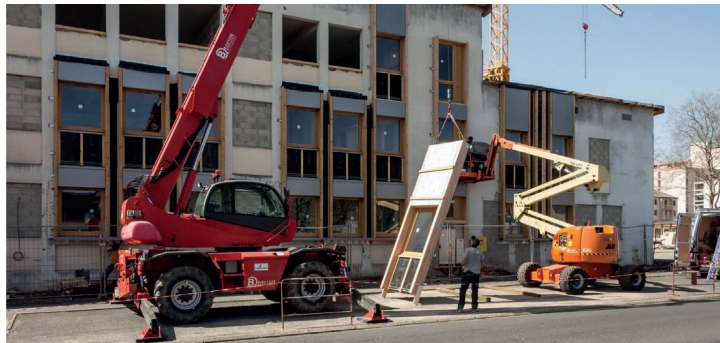
Levage et pose des façades composées de douglas, des menuiseries bois, des brises soleil orientables et de panneaux de bardage bois préfabriqués en atelier. ©Atelier du Rouget Simon Teyssou & associé
