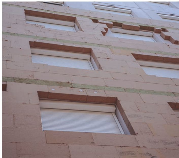
Application d'une isolation en fibre de bois sur les façades restantes, destinée à recevoir un enduit. ©Romain Lamberet
