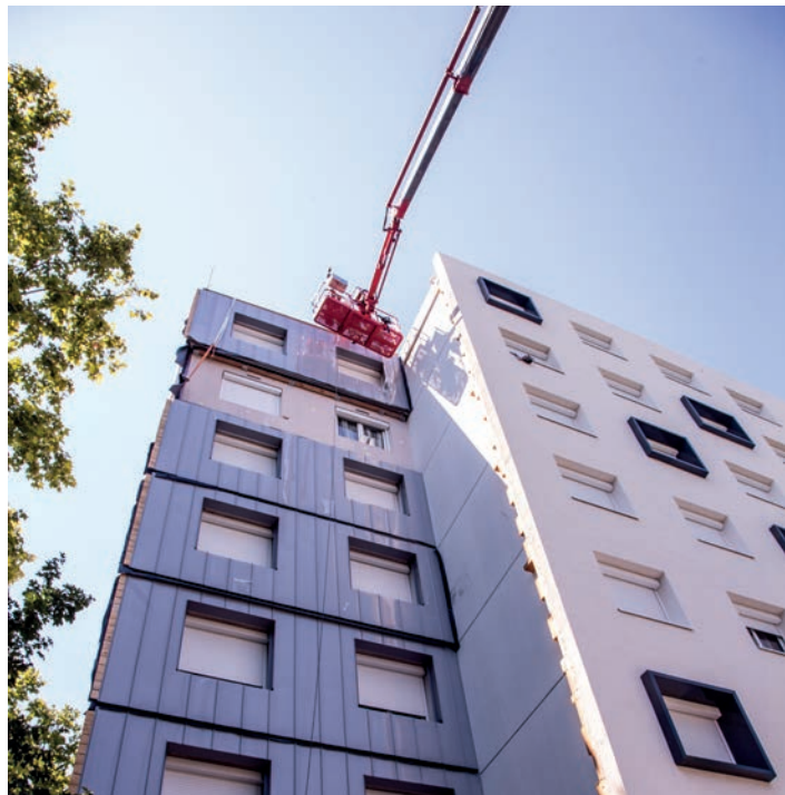
Pose des FOB préfabriquées, intégrant isolation et menuiserie sur 42% des façades de l'opération. ©Romain Lamberet
