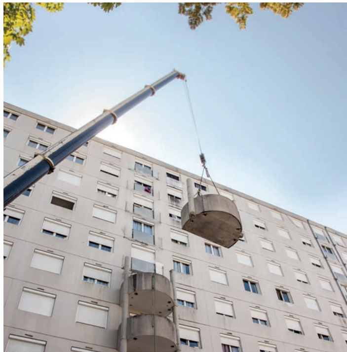
Dépose des anciens éléments et uniformisation des surfaces pour accueillir l'isolation thermique par l'extérieur. ©Romain Lamberet
